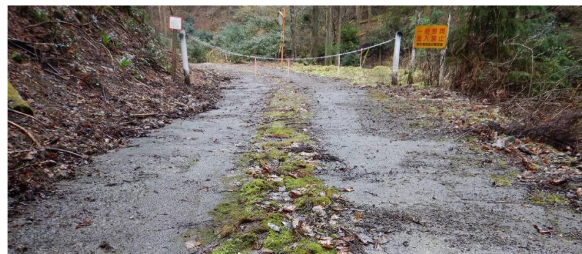
施工後5年（令和5年3月）
