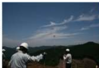
写真2 ドローンによる索張り
