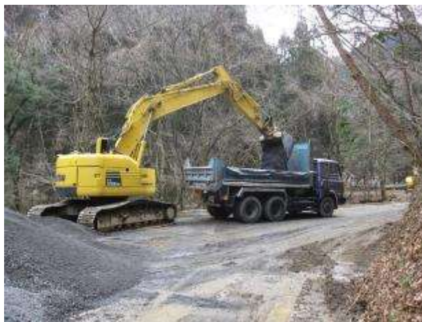
②ダンプ積み込み
