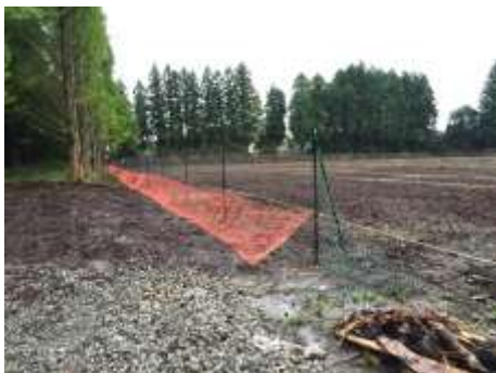
～16年10月 造成・整地・シカ被害防護ネット設置
