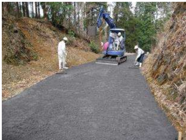
④バックホウ敷均し
