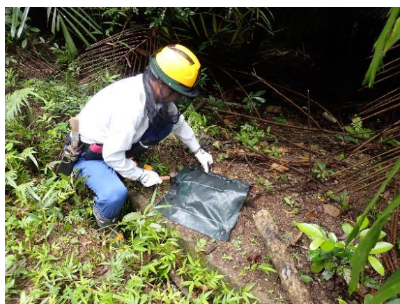
（写真 14）防草シートを設置する職員
