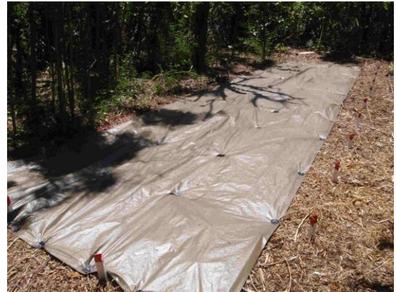
(写真7) 防草シート在来種手法別試験地
