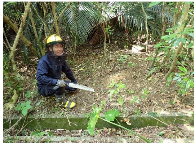
（写真 16）ギンネム伐採完了
