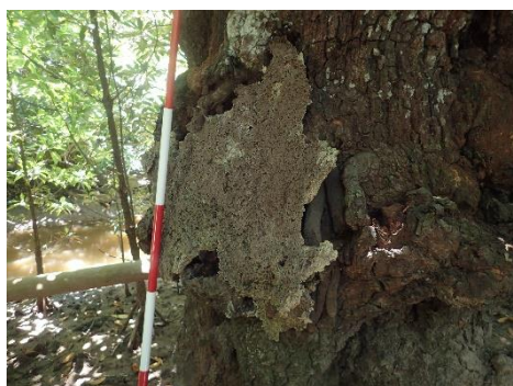
【写真 4 浮かび上がった充填物】
