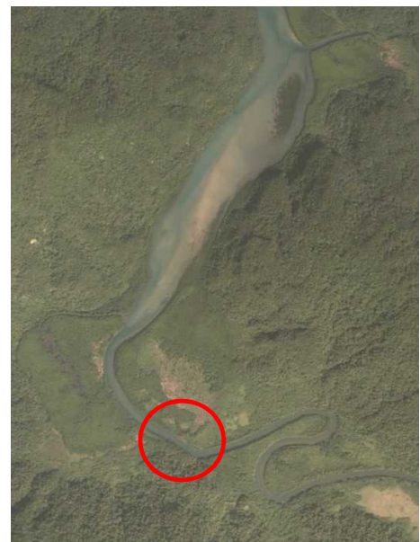
写真 14 仲良川の被害地
