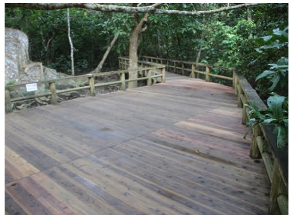
写真5 修繕後の観察デッキ
