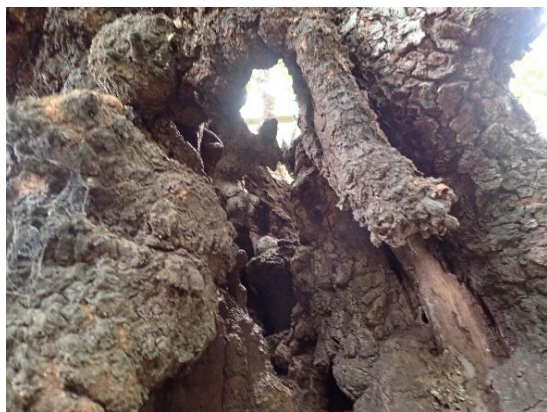
(写真 2 1) 樹幹内部の腐朽
