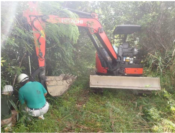
（写真12）重機を使って抜き取り作業
