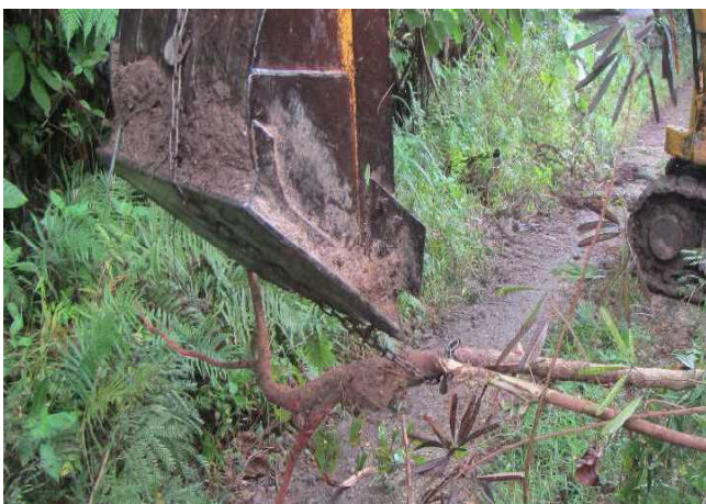
(写真11) 重機を使つての抜き取り作業
