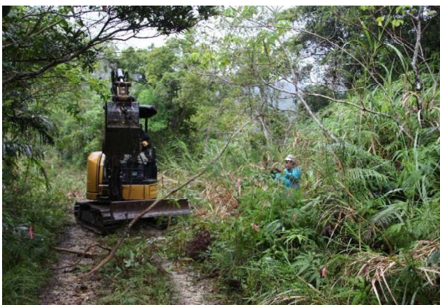
写真 13 重機を使っでの抜き取り作業
