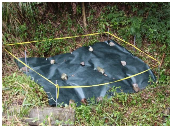
写真 4-3 防草シートによる被覆処理
