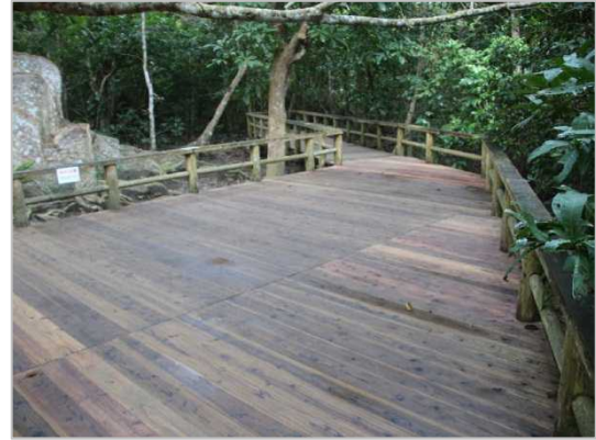
(写真 1-12) 観察木道デッキ(修繕後)
