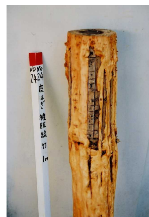
写真 9 孟宗竹×皮覆線 剥皮後、型枠巻込み状況
