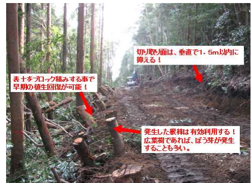
写真-2 作業路作設状況
