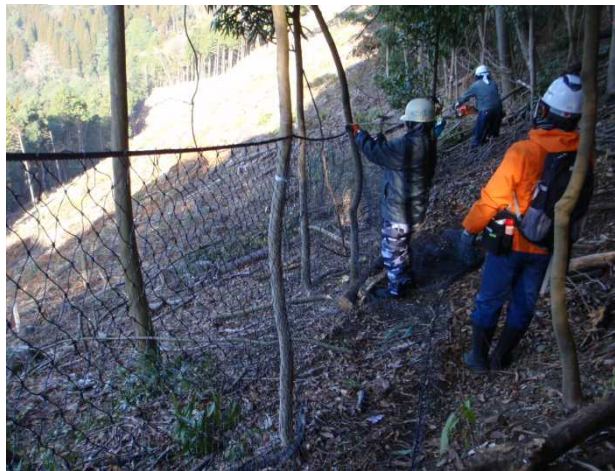
斜め張り(立木)
