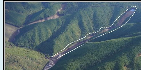
⑦愛賀合区域（田辺市鮎川） ・崩壊規模 0.77ha ・対策工：溪間工 山腹工 ※事業完了 移管済み
