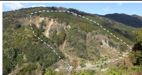
①上秋津区域（田辺市上秋津） ・崩壊規模 1.72ha ・対策工：山腹工 地下水排除工、溪間工
