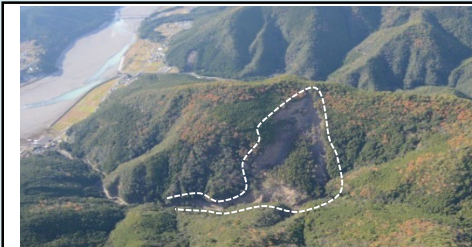
④下モ谷西側区域（田辺市本宮町上切原） ・崩壊規模 5.40ha ・対策工：溪間工 山腹工
