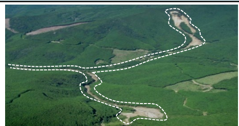
②本田垣内区域（田辺市西大谷） ・崩壊規模 3.70ha ・対策工：溪間工 山腹工
