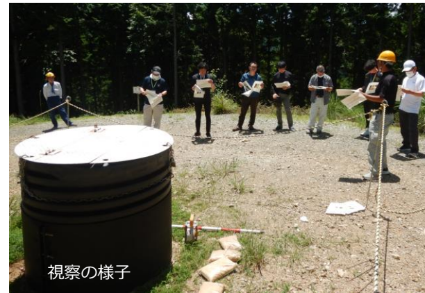
【大型配水管を利用した残渣処理】 (日高川町 西ノ河 (にしのごう) 国有林)
