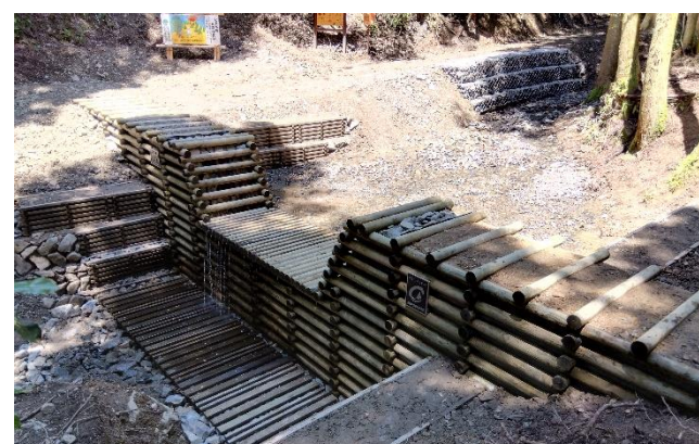
【木製校倉式床固工】 (和歌山市 紀泉高原（きせんこうげん）国有林)
