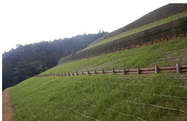
【丸太筋工】 (田辺市 民有林直轄治山上平治川（かみへいじがわ）区域)
