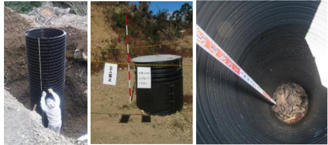
【大型配水管を利用した残渣処理】
