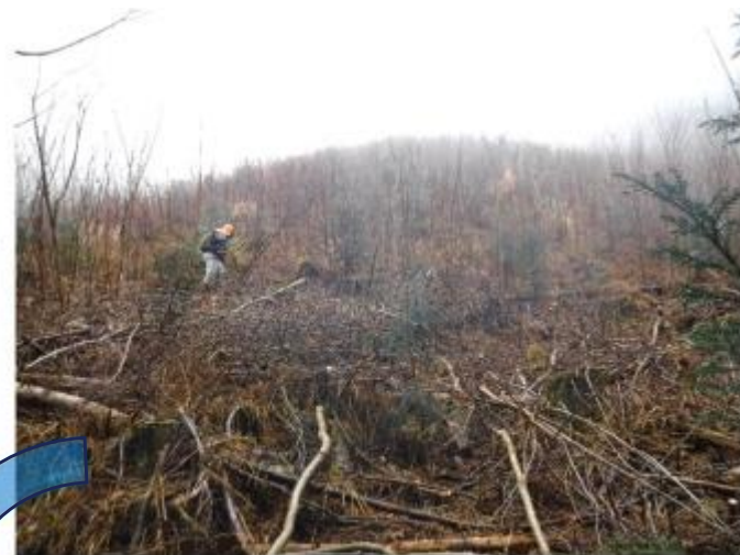
【冬下刈りの作業状況】
