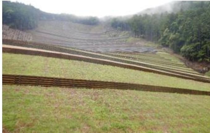
【木製枠筋工】 (田辺市 民有林直轄治山下毛谷西側 (しものたににしがわ) 区域)
