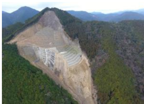
【山腹工】 かみへいしがわ (田辺市 紀伊田辺地区：上平治川区域)
