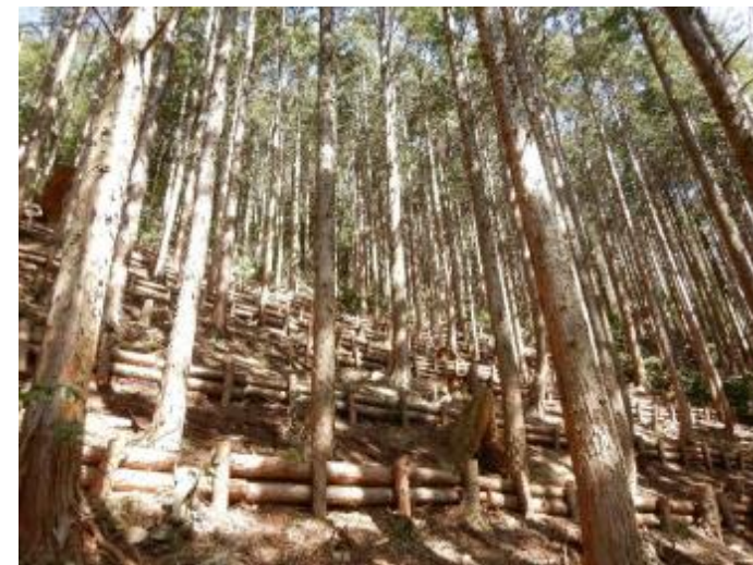
【保安林整備事業(本数調整伐・丸太筋工)】 (田辺市 公門谷(くもんだに) 国有林)
