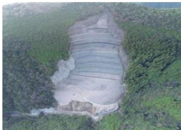
【山腹工】 しものたににしがわ (田辺市 紀伊田辺地区：下毛谷西側区域)
