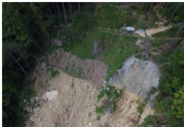
【斜面補強ネット工】 (田辺市 紀伊田辺地区：上秋津区域)
