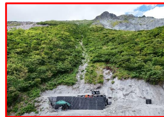
大山（一ノ沢）鋼製枠土留工施工地 （大山国有林：大山町）
