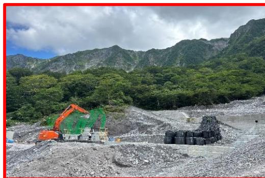
大山（元谷）床固工施工地（大山国有林：大山町）
