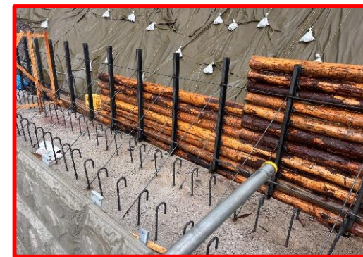
令和8年度床固工事における存置型枠の木材利用の状況 (大山国有林：大山町)
