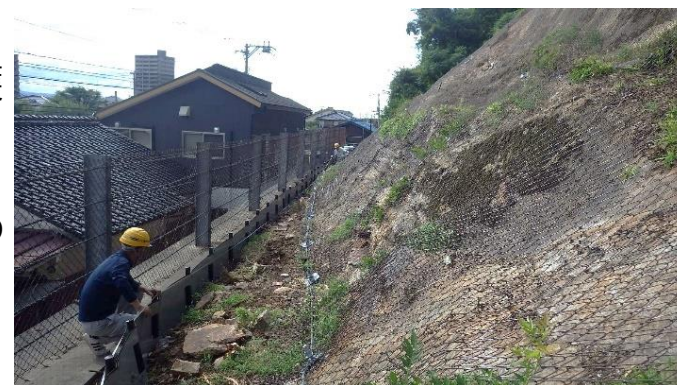
きゅうしょうざん 令和6年度山腹工施工地（旧城山国有林：鳥取市）
