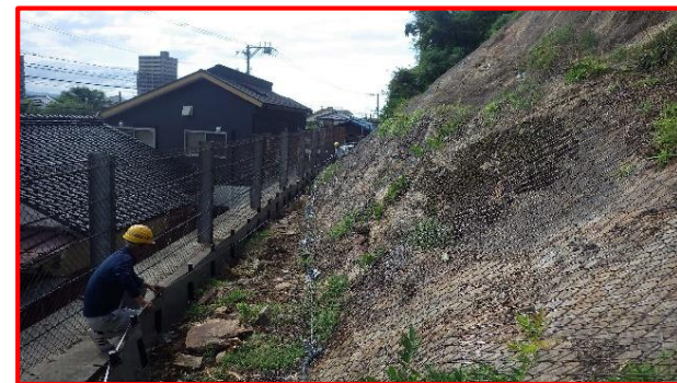
令和6年度山腹工施工地（旧城山国有林：鳥取市）
