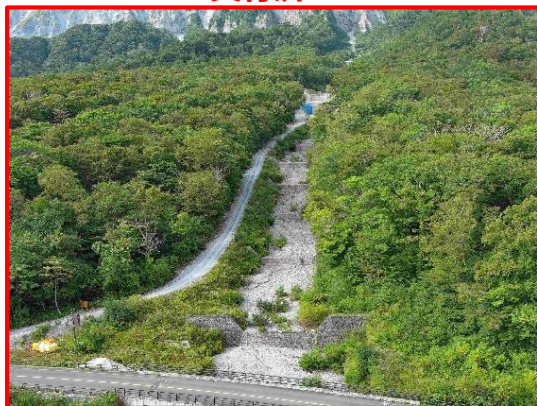
大山三ノ沢溪間工施工地（大山国有林：大山町）
