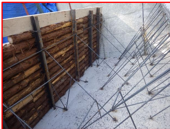
令和6年度溪間工事における存置型枠の木材利用の状況 (大山国有林：大山町)
