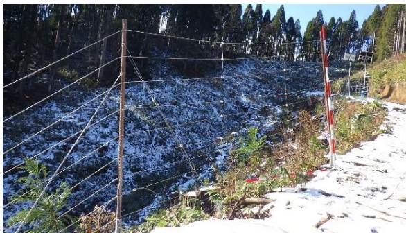
防護柵試験地の状況 (西鴨国有林：倉吉市)
