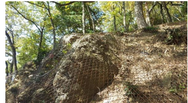
令和5年度山腹工施工地（旧城山国有林：鳥取市）
