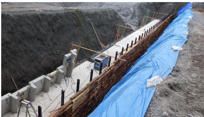
令和5年度床固工事における存置型枠の木材利用の状況 (大山国有林：大山町)
