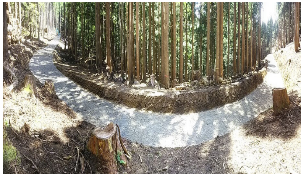
令和3年度林業専用道施工地 (小舟山国有林: 若桜町)
