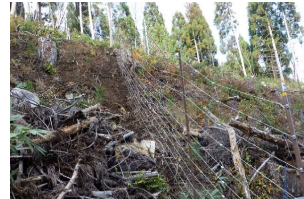
防護柵試験地の様子 (西鴨国有林:倉吉市)
