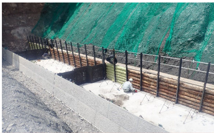
令和4年度床固工事における存置型枠の木材利用の様子 (大山国有林: 大山町)
