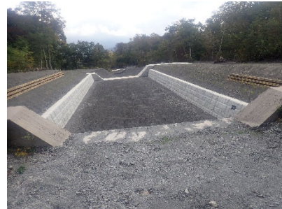
令和2年度護岸工施工地 (大山国有林:大山町)
