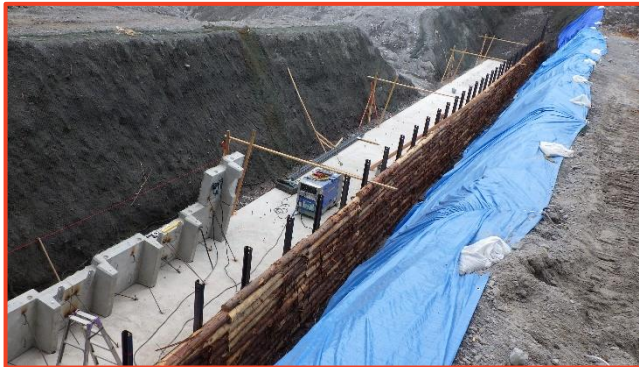
令和5年度床固工事における存置型枠の木材利用の様子 (大山国有林: 大山町)
