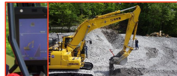
ICT建機(3DMC油圧ショベル)による機械遠隔操作の様子
