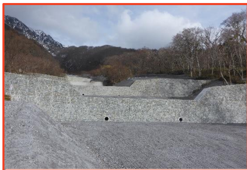
令和5年度床固工施工地(大山国有林:大山町)
