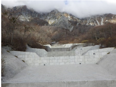
令和2年度床固工施工地 (大山国有林:大山町)
