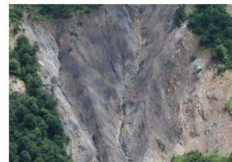
【ヘリによる吹付状況(完了後)】
