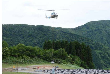
【ヘリによる施工状況】
