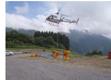
【ヘリによる施工状況】
