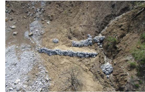
【ヘリによる施工完了状況】
