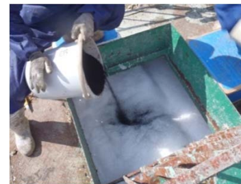
【侵食防止工用資材の作製状況】
