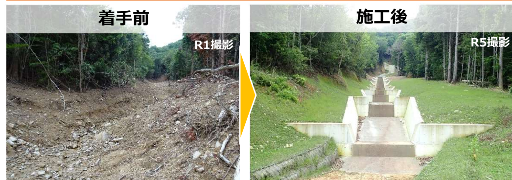
▲【高屋区域：溪間工 施工状況】
