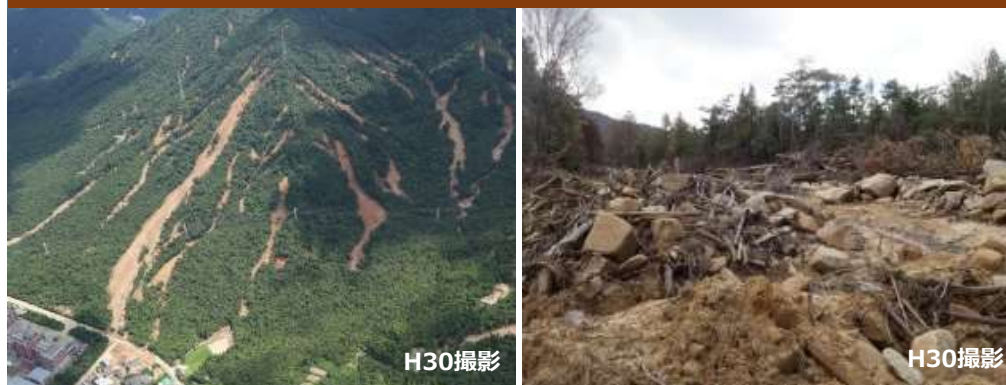
▲【大規模崩壊地】 (黒瀬区域)
