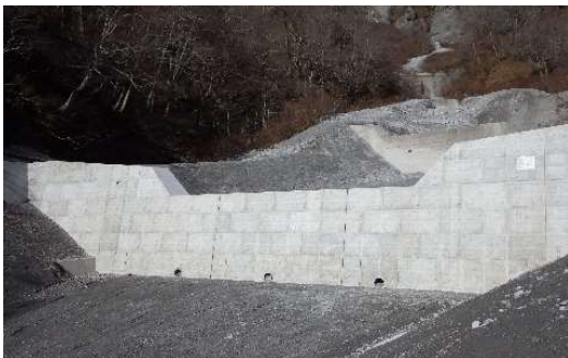
▲【大山国有林（南壁：二ノ沢） 溪間工 施工状況】
