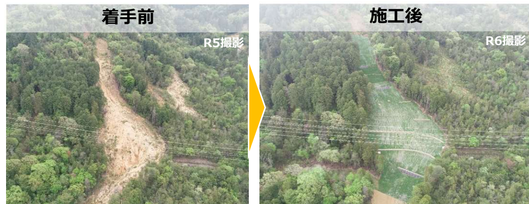
▲【黒瀬区域：山腹工 施工状況】
