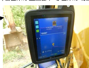
▲ICT建機内のモニター画像
