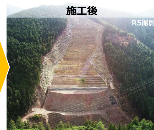
▲【天川村 天川区域 坪内工区：山腹工 施工状況】
