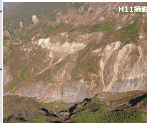
▲【山腹荒廃地】(湯の谷上流部)
