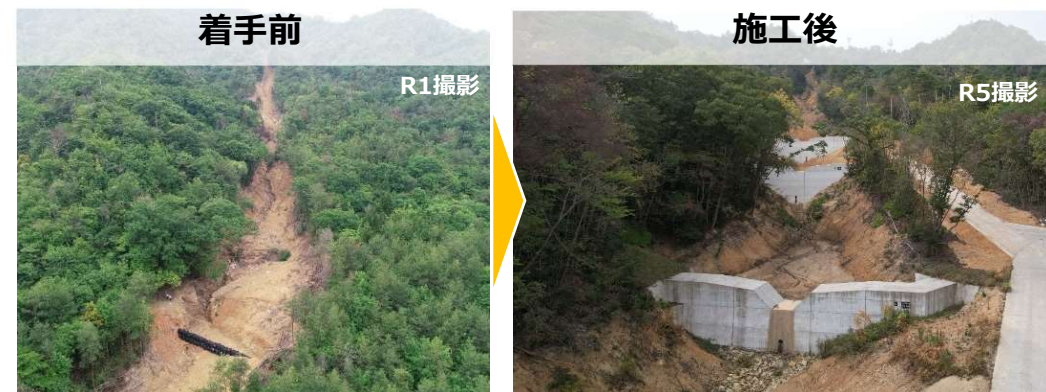
▲【八本松区域：溪間工 施工状況】
