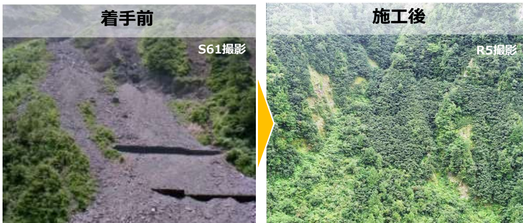
▲【湯の谷中流部：山腹工（ホ-22）施工状況】
