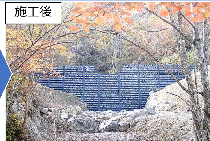
▲【溪間工施工事例】三重県多気郡大台町 大杉谷国有林（三重森林管理署）
