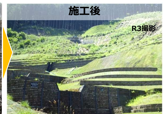
▲ 【本田垣内区域：山腹工・溪間工 施工状況】
