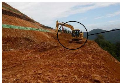
▲ICT建機による掘削作業状況
