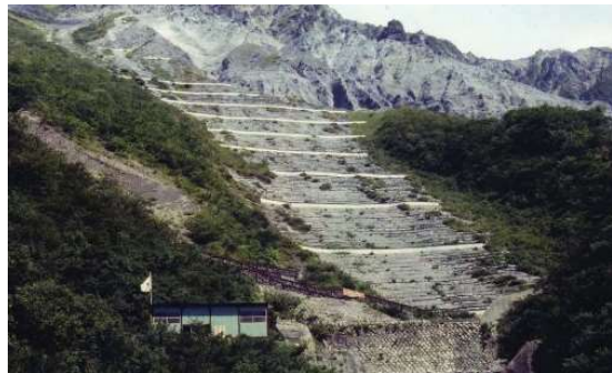
▲【大山国有林（南壁：一ノ沢） 昭和40年代の治山工事】
