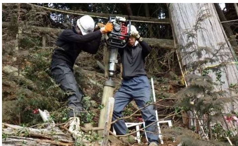
写真-2 杭打設
