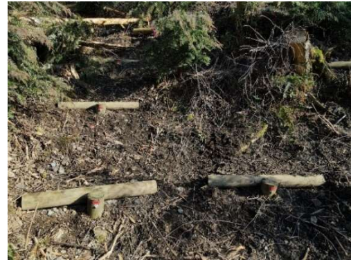
写真-4 施工後の様子
