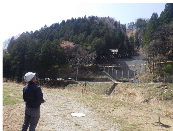
写真-1 UAV写真測量の様子
