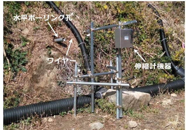
写真-2 水平型孔内伸縮計 (BH-A0-2)
