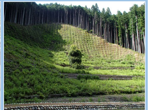
施工から3年後 (H29.8)
