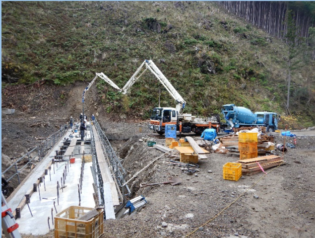
(本田垣内区域：治山ダム工施工中)
