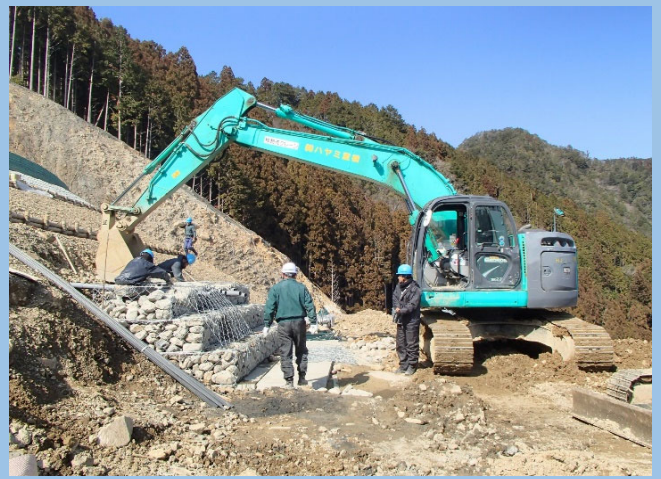
(上平治川区域：山腹工施工中)
