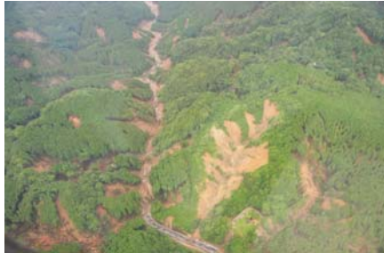
奈良ヶ谷川(朝倉市)の山腹崩壊状況
