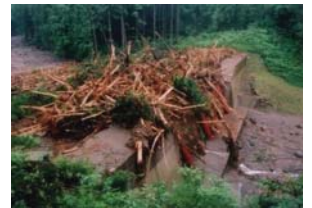
流木捕捉式治山ダム
