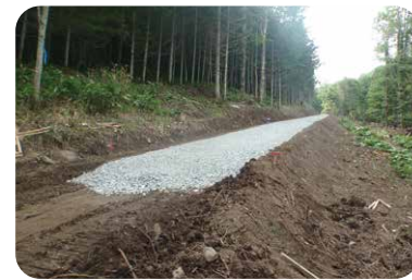
新設中の林道の様子。林道規格に合わせて地山を掘削し、上層路盤となる砕石を敷設しています。
