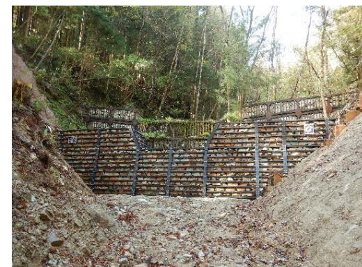
完成した治山施設（鋼製杵谷止） 椋谷山国有林（吉賀町）
