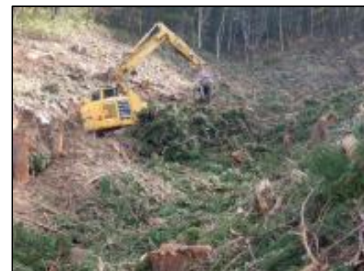
一貫作業システム（重機による地拵） 今山国有林（美郷町）
