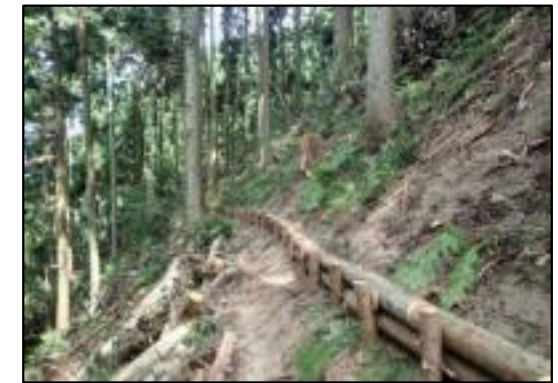
丸太筋工（間伐木利用） 三谷国有林（雲南市）
