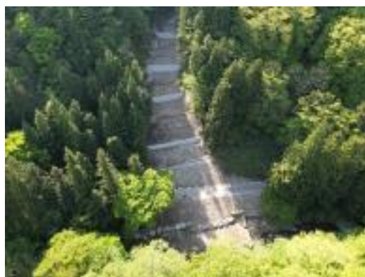
施工後（令和5年6月）
