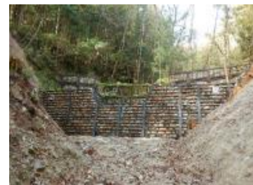
完成した治山施設（鋼製棒谷止） 椴谷山国有林（吉賀町）
