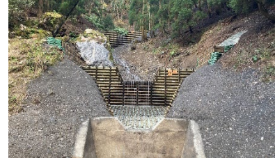
▲ 治山対策（溪間工事）
