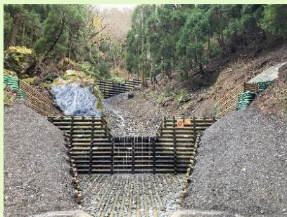
治山事業：溪間工(治山ダム)
