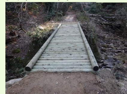
木製歩道橋整備
