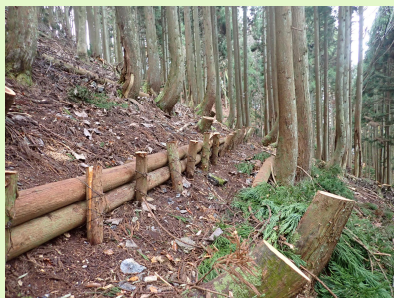
保安林整備：本数調整伐・筋工
