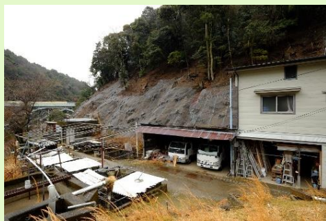
山腹工 大津市関寺国有林
