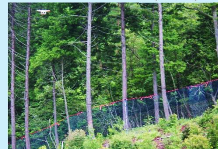
ドローンによる防護柵点検
