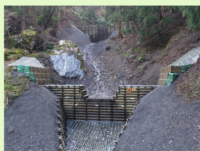
治山：溪間工（治山ダム）
