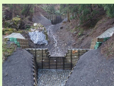
治山：溪間工（治山ダム）
