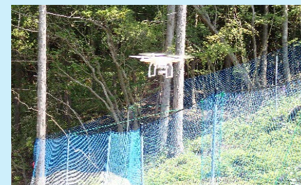
ドローンのよる防護柵点検
