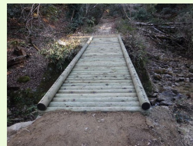
木製歩道橋整備
