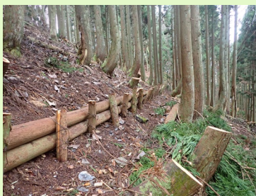
保安林整備：本数調整伐・筋工
