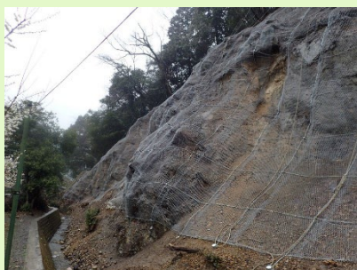
山腹工 大津市関寺国有林
