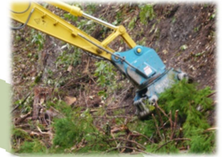
グラップルにより林地を整理
