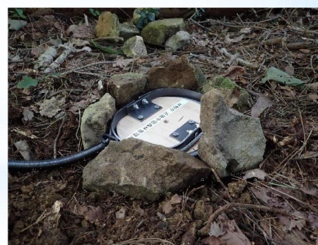
⑧塩ビ管の上に踏み板をセット
