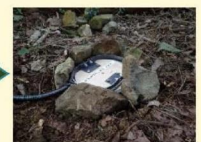
③堀び管の上に踏み板をセット
