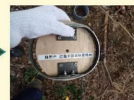
②ワイヤーを根付けし、踏み板にワイヤーをセット
