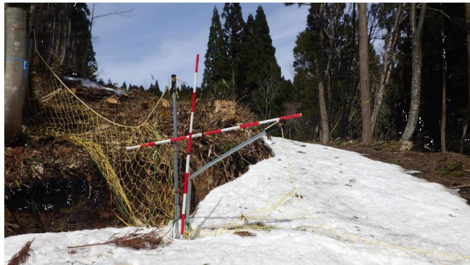
支柱の損傷
