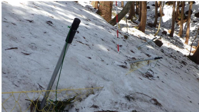
支柱の倒壊、ネットの垂れ下がり
