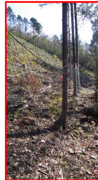
ステンレス入りネット縦張り
