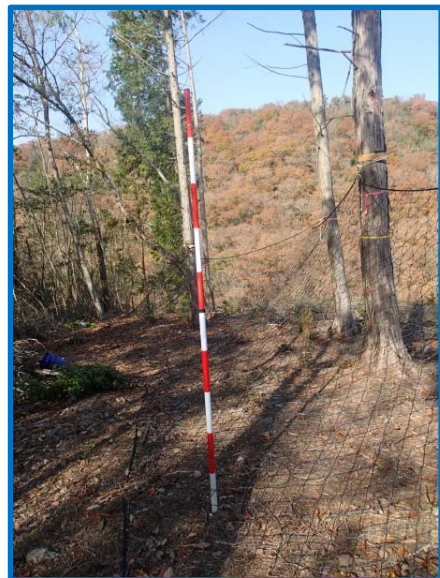
ステンレス入りネット斜め張り
