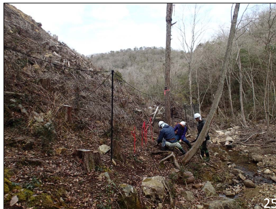
アンカーの増設状況
