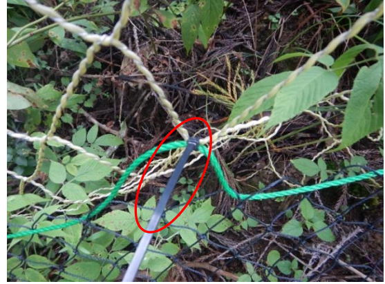
国有林の仕様 (結束バンドによるスカートネットの固定)
