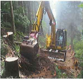
フェラーバンチャザウルスによる搬出作業道作設
