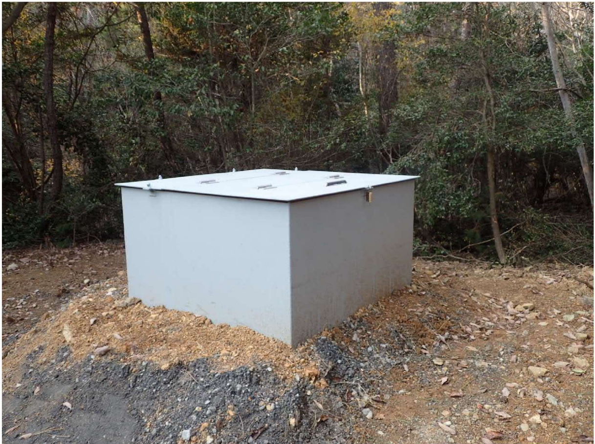
写真：大型排水管の埋設状況（たつの市新宮滝谷国有林）
