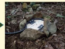
③塩ビ管の上に踏み板をセット
