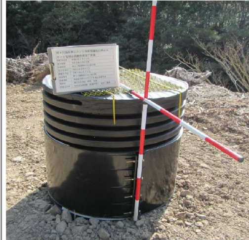
埋設した大型排水管
