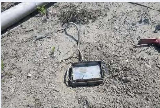
⑦ 穴に踏み板を置く
