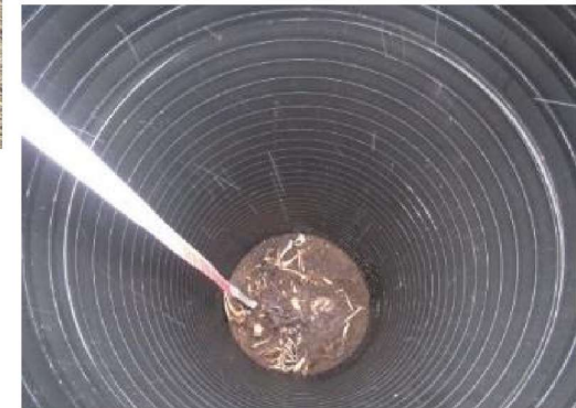
埋設した大型排水管 (内部)
