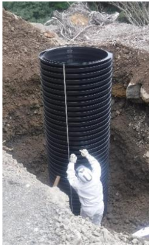
地上部1m、地下部3m程度で埋設
