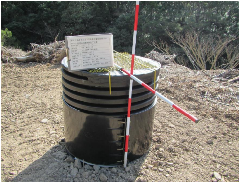
埋設した大型排水管
