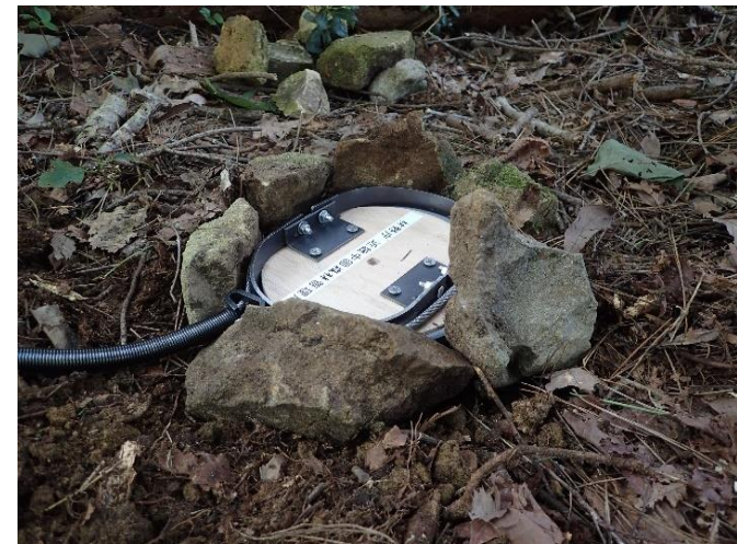
⑧ 塩ビ管の上に踏み板をセット
